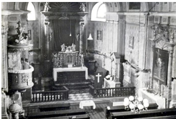
oprava elektřiny rok 1970
