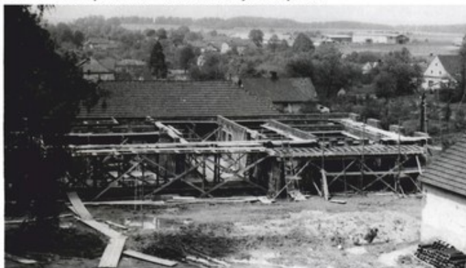
Výstavba hospody k sálu
