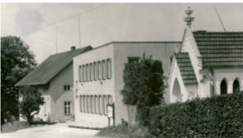
Administrativní budova JZD (postavena 1974 – 1976)
